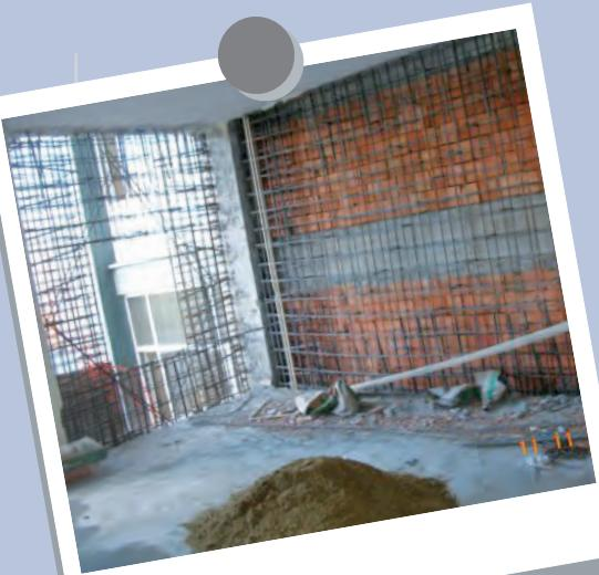
**Şekil 16.** Betonarme çerçeve düzlemi içine perde duvar eklenmesi.
