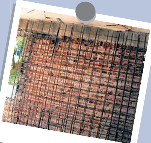
**Şekil 17.** Betonarme çerçeve düzlemine bitişik perde duvar eklenmesi.
