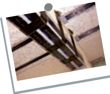
**Şekil 4.** Kırışların lifli polimerle sarılması.
