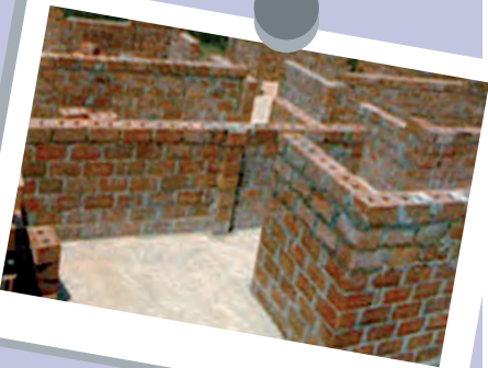
Şekil 61. İyi bir yığma duvar üretim örneği.
