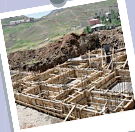
Şekil 22. Tekil temel ve sürekli temel örnekleri.
