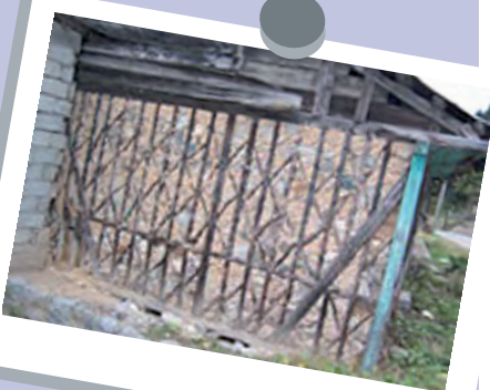
Şekil 13. Karma taşıyıcı sistem.
