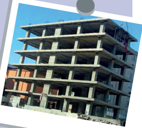
Şekil 11. Betonarme perde-çerçeve taşıyıcı sistem.
