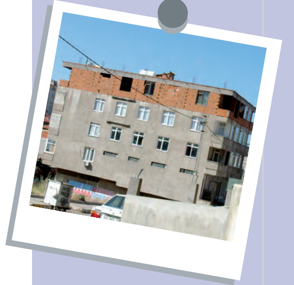
Şekil 47. Kat sayısı artırılmaya hazır bina.
