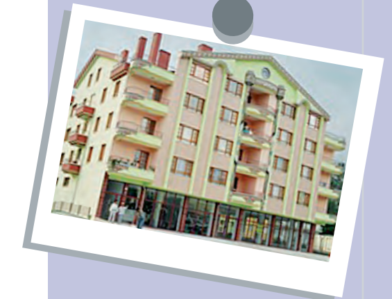
Şekil 30. Sıkça uygulanan giriş katında dolgu duvar bulunmayan konut.
