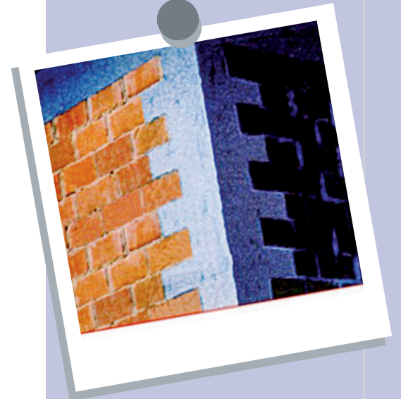
Şekil 51. Birbirine dik bağlanan taşıyıcı duvarların birleşimi.
