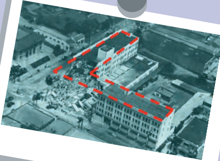
Şekil 26. "L" şeklinde geometriye sahip binada meydana gelen hasar (1906 San Fransisco).
