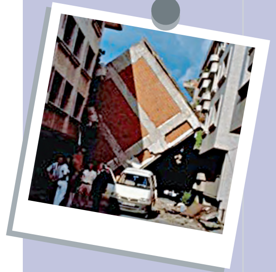
Şekil 24. Hatalı temel tasarımı ve zemin etüdü yapılmamış yapıların deprem davranışı.
