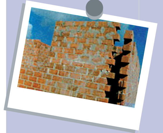
Şekil 56. Düşey hatıl boşluğu.
