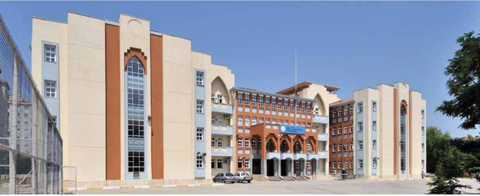
Yeniden Yapımı Tamamlanan Emine ve Hasan Aytaçman İlköğretim Okulu
