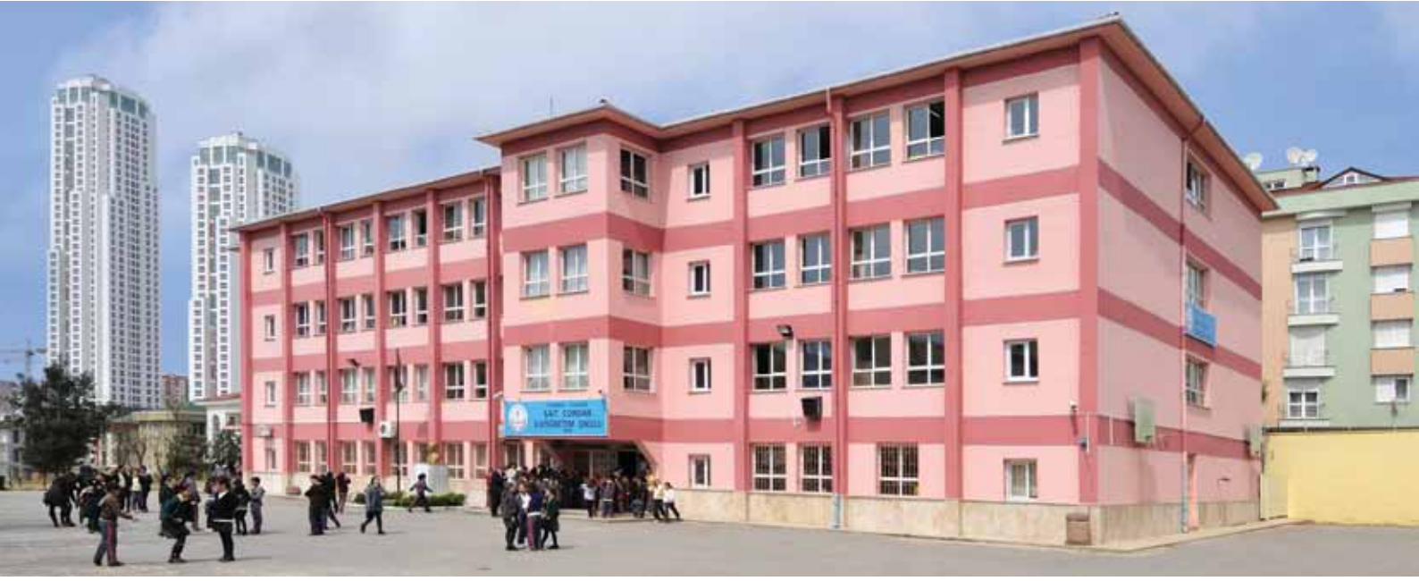
Sait Cordan İlköğretim Okulu Güçlendirme Aşamaları
