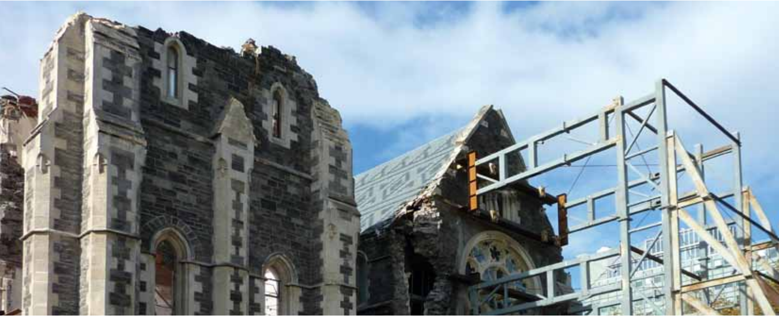
Tarihi Yapılarda Güçlendirme Çalışması Örneği, ChristChurch Katedrali, Yeni Zelanda
