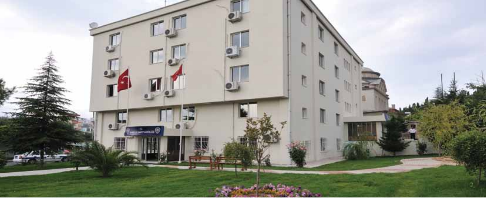
Güçlendirilmesi Tamamlanan Pendik İlçe Emniyet Müdürlüğü
