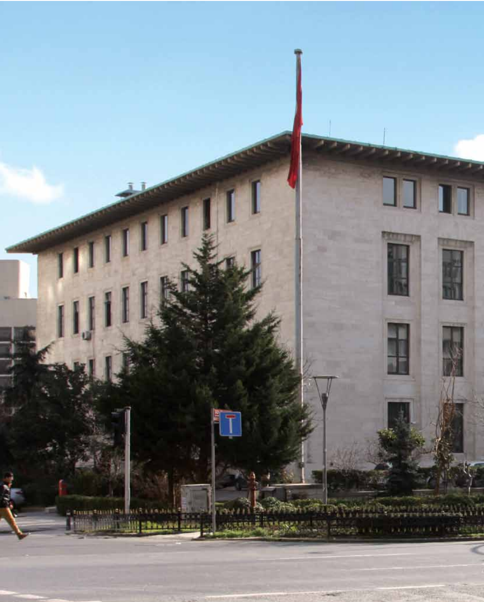
TRT İstanbul Radyo Binası
